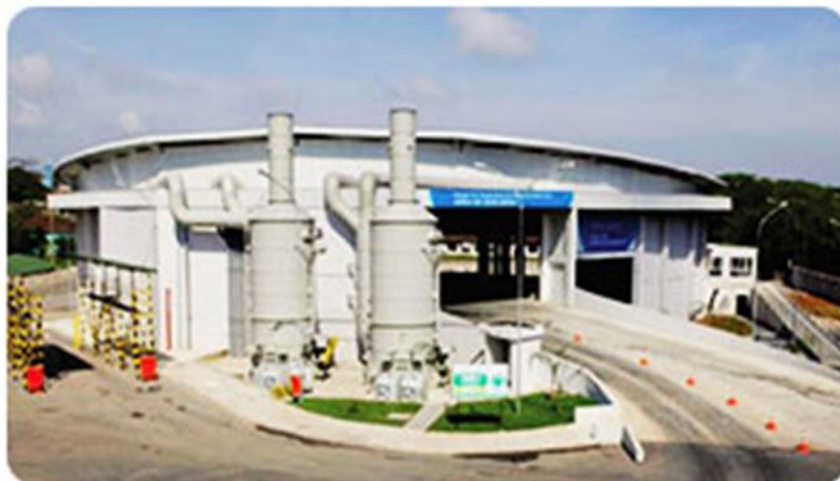
Estação de Transferência da Empresa Ciclus em Santa Cruz – Rio de Janeiro
